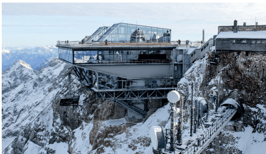
Zugspitzbahn-Projekt 2019 der Coatinc PreGa in Kreuztal; Foto: Bayerische Zugspitzbahn Bergbahn AG
